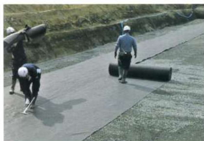
1 保護シート敷設
